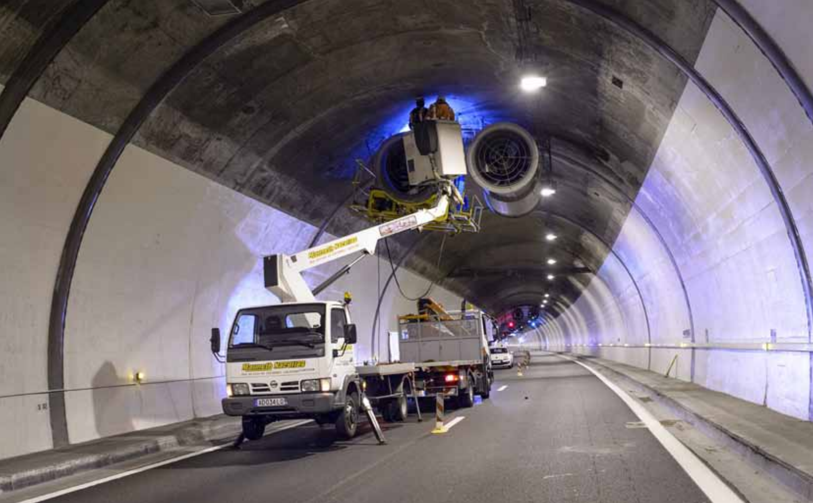
A40 - Fermeture de l'autoroute entre Bellegarde et Saint-Martin-du-Fresne, permettant la réalisation de travaux sous le tunnel de Saint-Germain.
