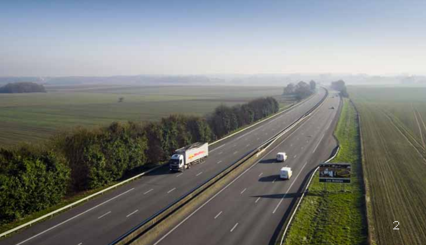
1 A41 Nord - Tunnel du Mont Sion sur l'autoroute Liane entre Annecy et Genève. 2 A13 - Fontaine Bellanger.
