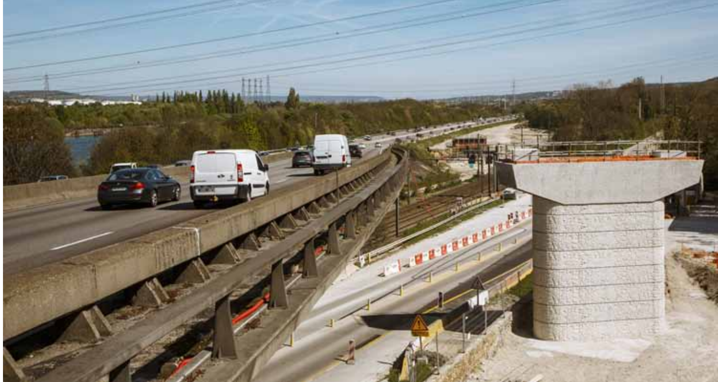
A13 - Travaux d'élargissement du tablier du viaduc de Guerville.
